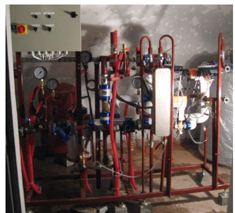
Fernwärmeverteilerstation im Keller
